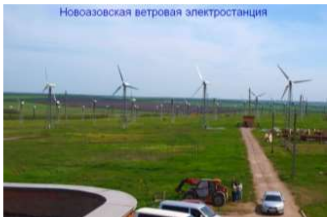
Рисунок 3 –Ветровая электростанция в Новоазовском районе ДНР
