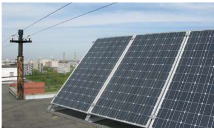
Рисунок 1 – Солнечные коллекторы на крыше машиностроительного цеха
